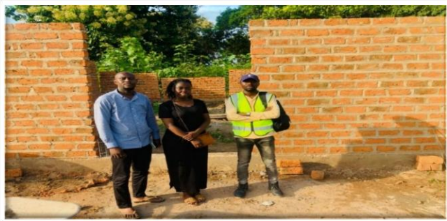
Les membres du CERAPE (à gauche) avec l'entrepreneur, devant le bâtiment en construction destiné au stockage du maïs à Kayes
